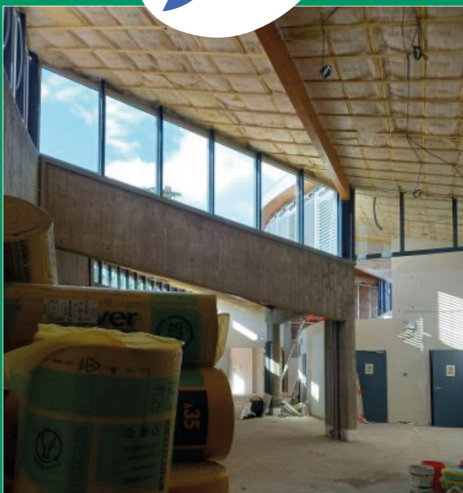
Chantier du projet de rénovation de l'école de Vourles (69)
