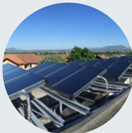
Photo : Projet solaire thermique combinant pompe à chaleur et champ solaire à Præstø au Danemark.
