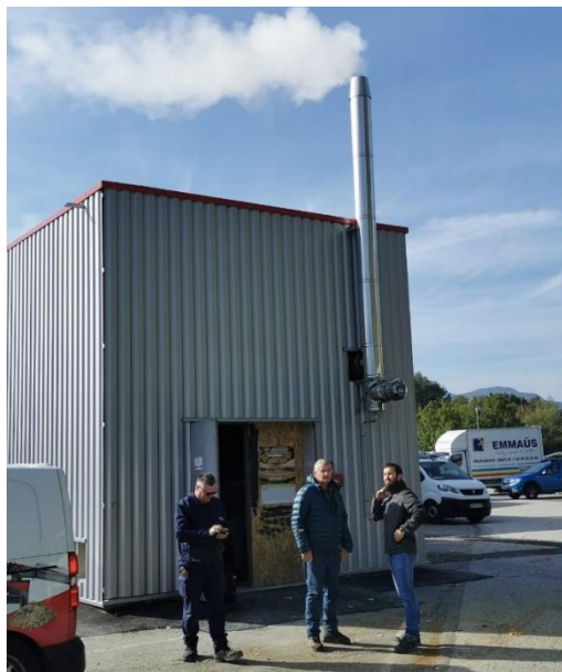
Chaufferie bois d'Emmaüs à Annemasse (74)
