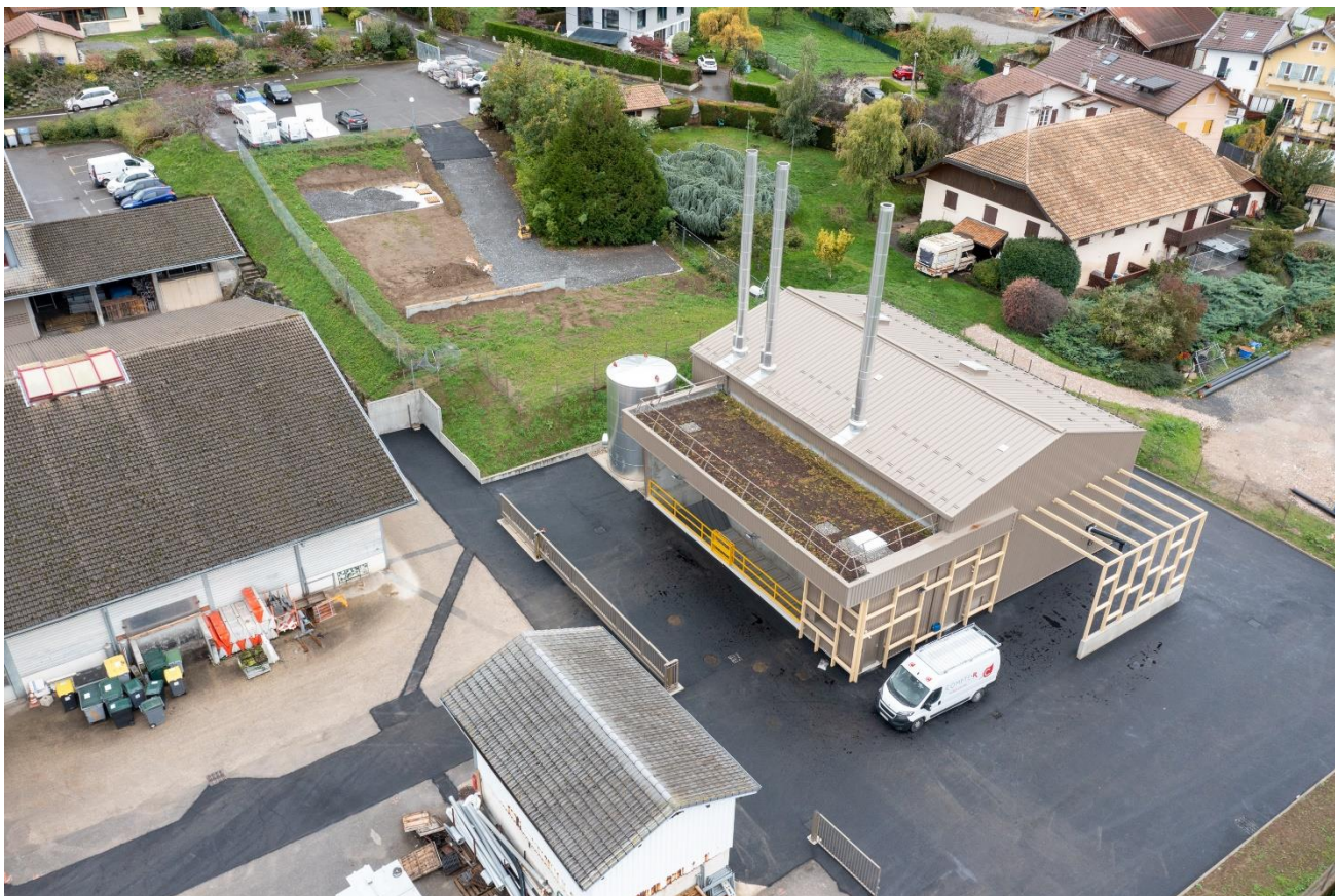
La chaufferie et le réseau public de chaleur des Hauts d'Evian (74)
