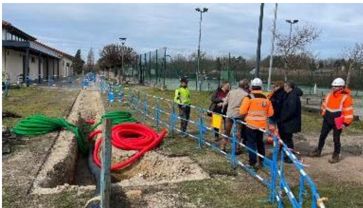
Chantier du réseau de chaleur d'Estrablin @Moustapha L'Haoua
