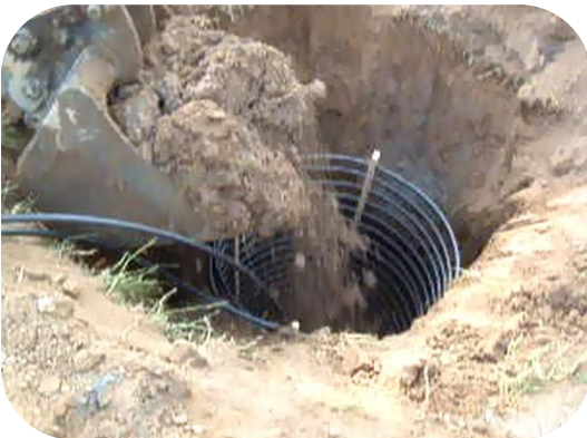
Mise en œuvre d'une corbeille
