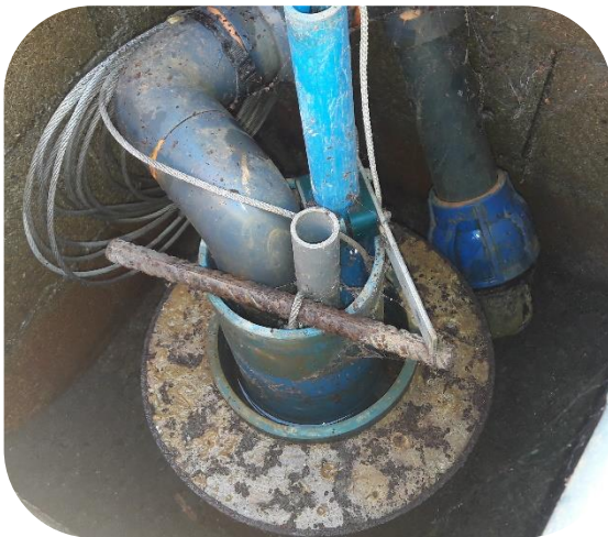
Doublet géothermique (puisage et réinjection)
