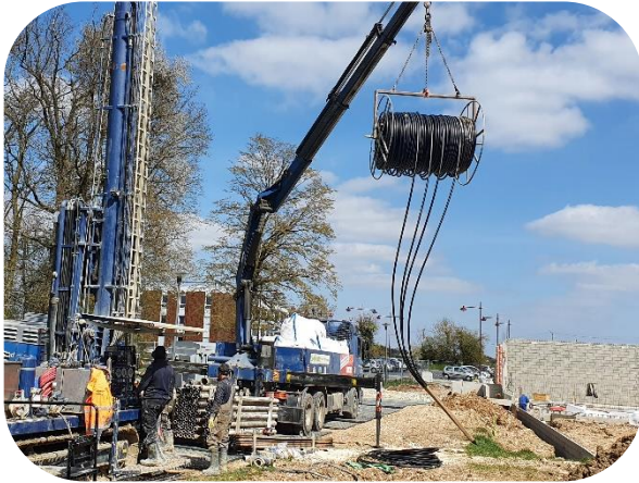
Mise en œuvre de sondes géothermiques
