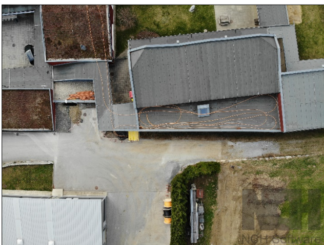
Phase de construction à Thannhausen
