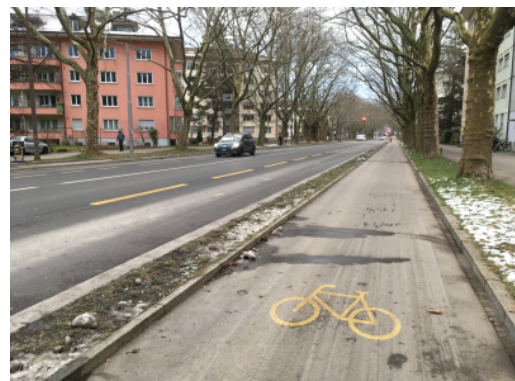
Piste cyclable unidirectionnelle avec séparation du trafic le long de la Winkelriedstrasse, Berne
