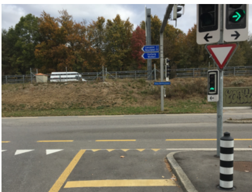
Feux pour cyclistes à la Murtenstrasse, Berne
