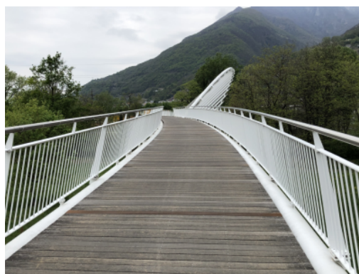
Passerelle à Locarno
