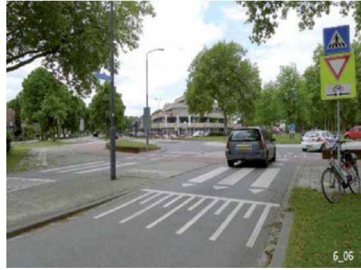
Décrochement vertical permettant d'abaisser la vitesse des automobilistes au carrefour aux Pays-Bas (source: OFROU & Conférence vélo, 2021)
