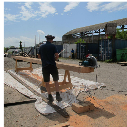
Réalisation_ Charpenterie lyonnaise Réalisation de pergolas et consoles par des charpentiers.
