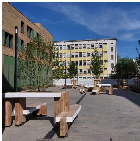
Réalisation_ Lycée Brossolette Chantier participatif avec les lycéens Fabrication par un artisan du mobilier
