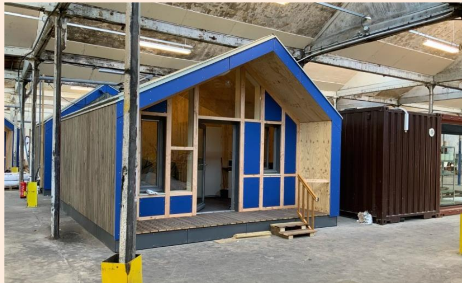
Solives bois, lames bois pour platelage, isolant, bardage extérieur, menuiseries, bois mélaminé, portes, luminaires, CE Habitat d'urgence à Villeurbanne (Alynéa, Atelier 43, les toitures montiliennes)
